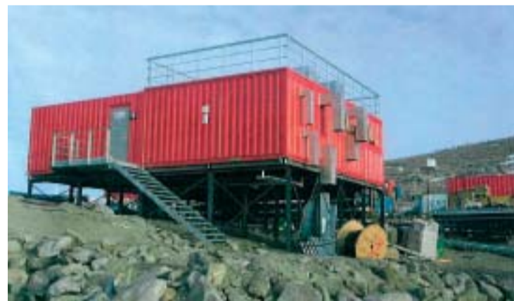
Troll 1 forskningsstasjonen i Antarktis ligger på permafrost og stiller høye krav til det byggetekniske.
